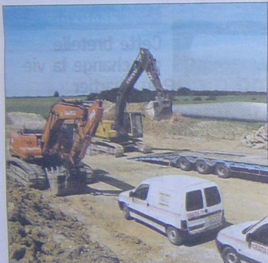
HETOMESNIL, ROUTE DE CONTEVILLE. VENDREDI. Impressionnant, le chantier vient de débuter. Les pales de la première éolienne oisienne sont posées dans le champ. (L.P./P.C.)
